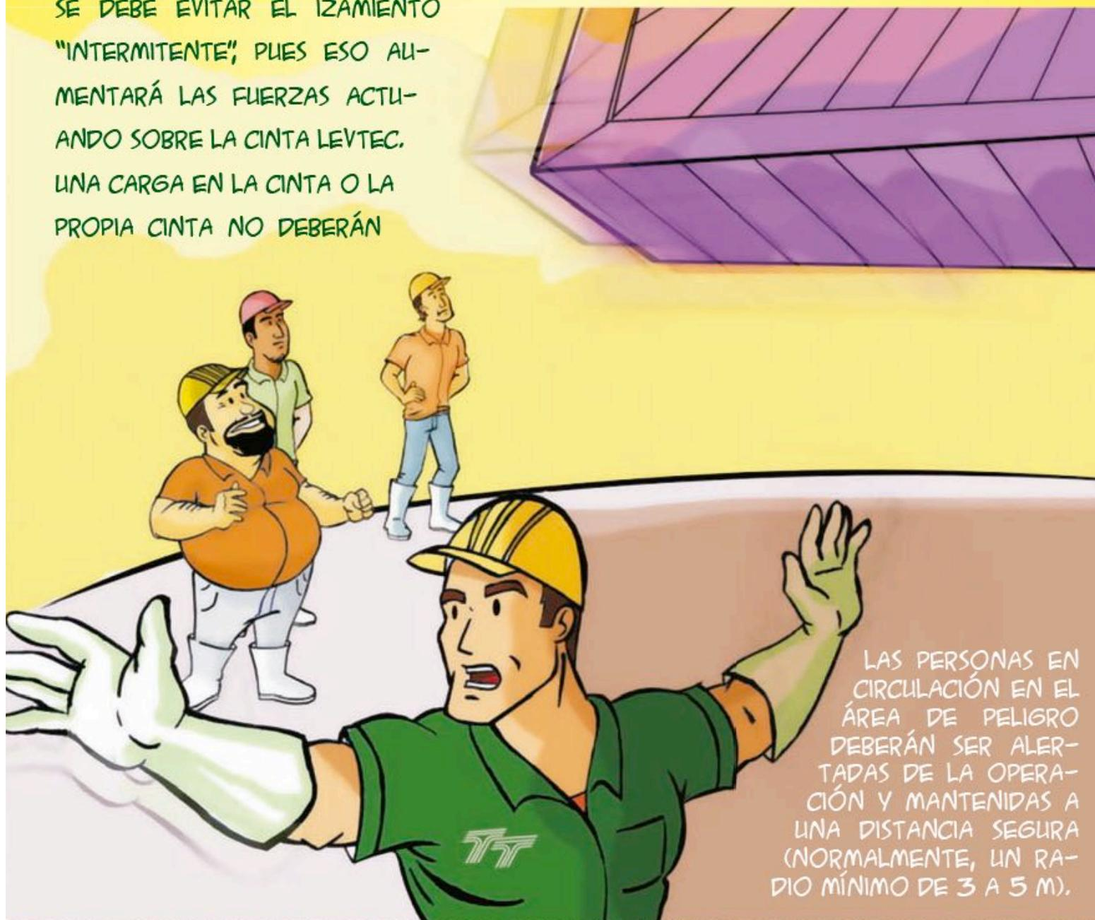
LAS PERSONAS EN CIRCULACIÓN EN EL ÁREA DE PELIGRO DEBERÁN SER ALERTADAS DE LA OPERACIÓN Y MANTENIDAS A UNA DISTANCIA SEGURA (NORMALMENTE, UN RADIO MÍNIMO DE 3 A 5 M).
